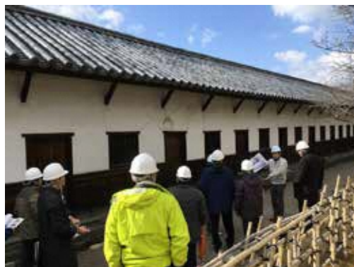
福岡城南丸多聞櫓の修理
