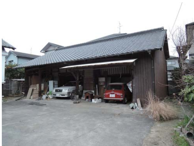
17 納屋 外観 北東から
