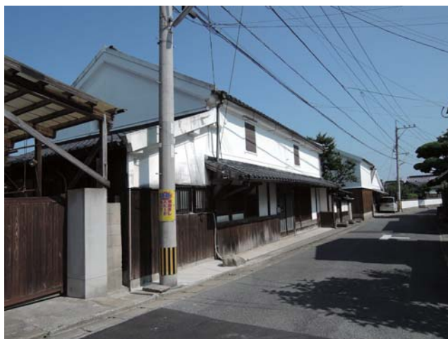
02 主屋 外観 南東から
