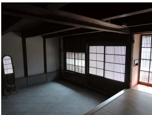
03 主屋 店舗部 土間
