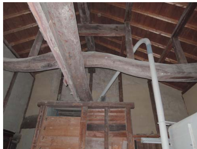
18 納屋 内部 小屋組 北から
