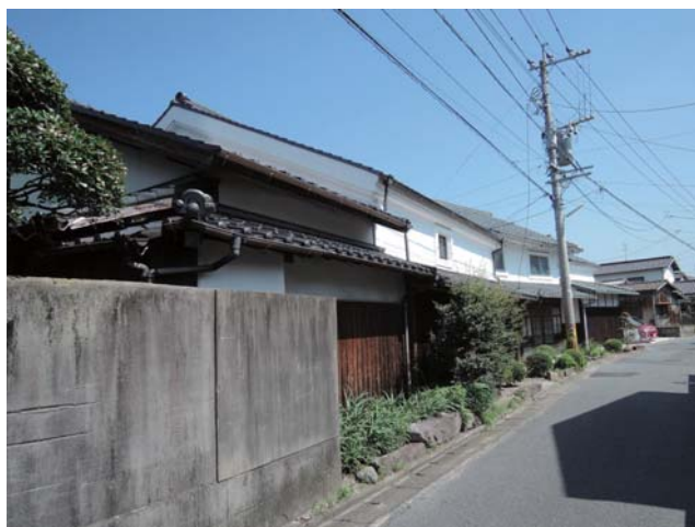
02 主屋 外観 南東から
