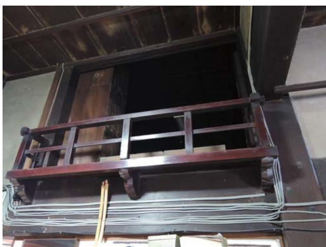
05 主屋 店舗部 2階部分
