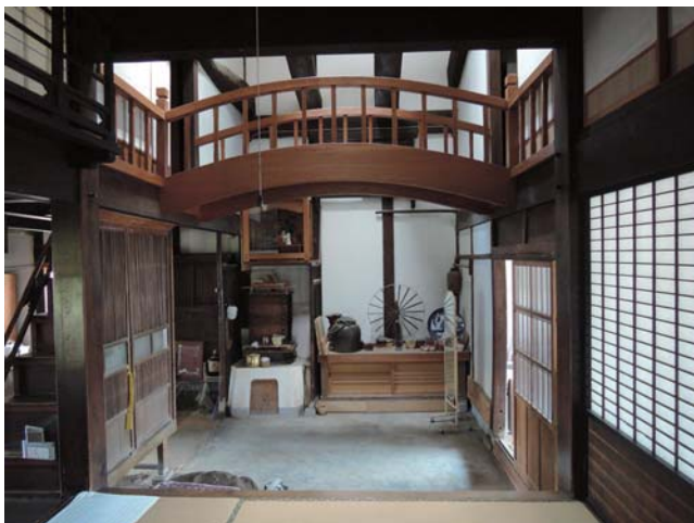
07 主屋 店舗部 ナカエの間から土間
