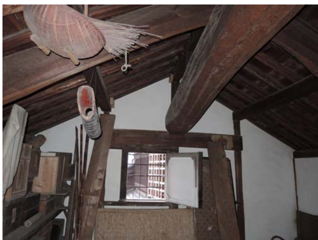
09 土蔵 内部 小屋組
