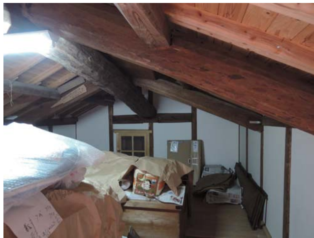
16 新蔵 内部 小屋組 東から
