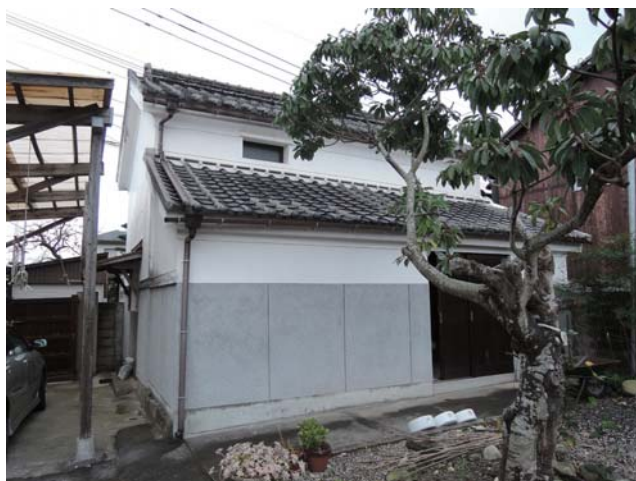
08 土蔵 外観 西から
