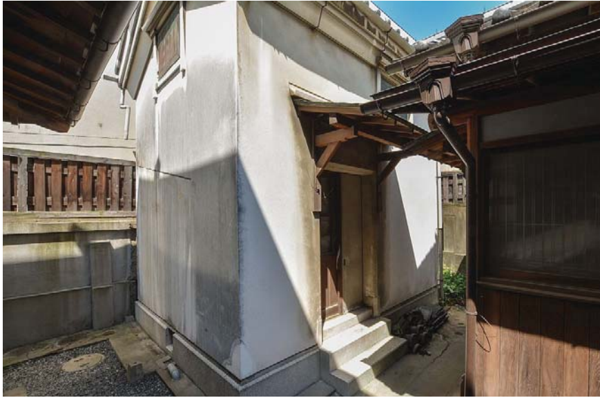
写真07 松村家住宅 土蔵 外部
