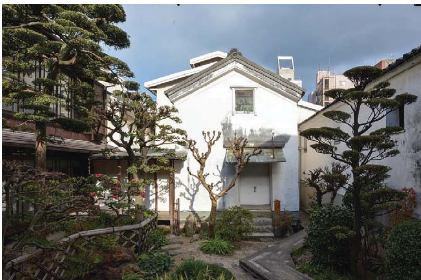
写真15 ジョーキュウ醤油 米蔵 外部
