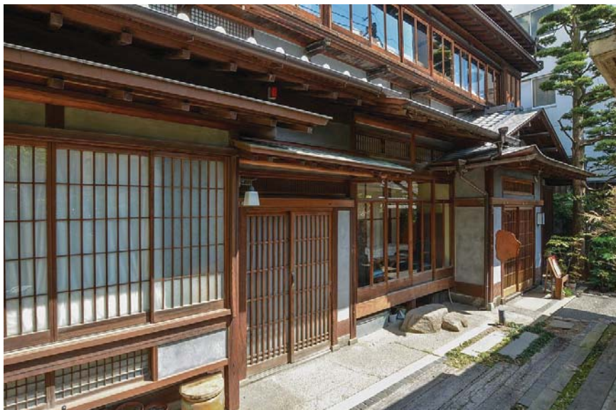
写真02 松村家住宅 主屋 玄関まわり
