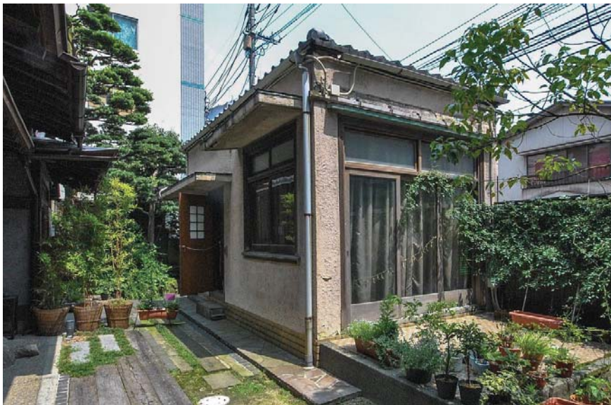
写真05 松村家住宅 洋館 北西面
