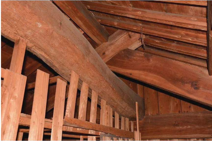
写真16 ジョーキュウ醤油 米蔵 小屋組
