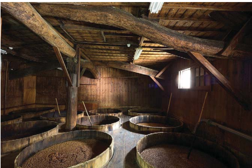
写真18 ジョーキュウ醤油 仕込蔵 内部
