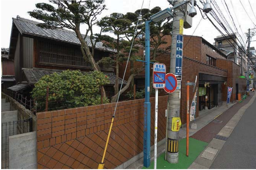
写真10 ジョーキュウ醤油外部と 表座敷外部
