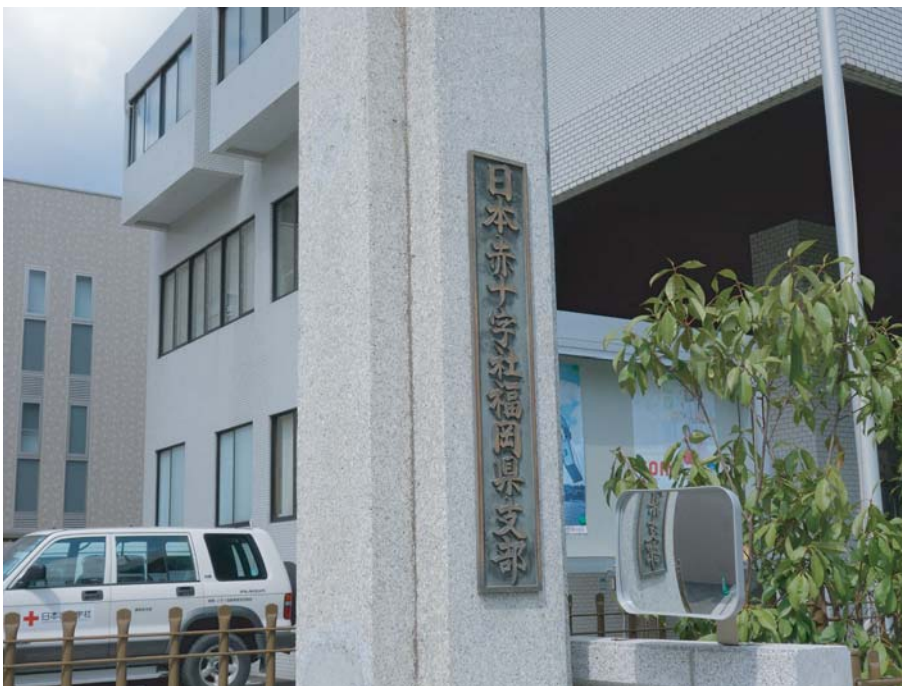
日本赤十字社福岡県支部 旧正門門柱 現況写真 部分（銘板）
