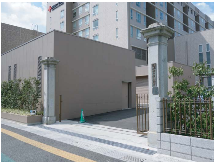
日本赤十字社福岡県支部 旧正門門柱 現況写真（北から）
