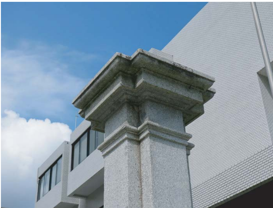
日本赤十字社福岡県支部 旧正門門柱 現況写真 部分（頂部飾り）
