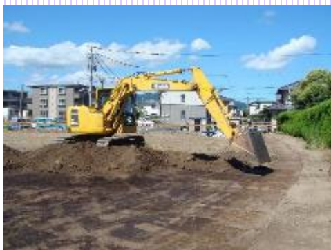
重機で表土を除去
