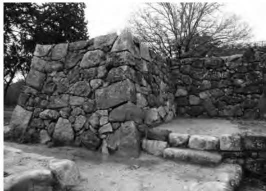
2. 保存修復工事完了後 (北東から)
