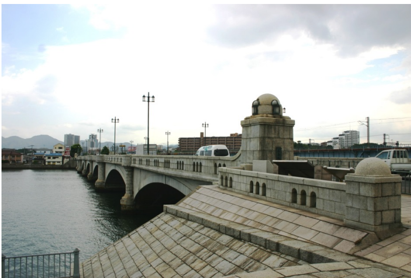
親柱及び袖柱は花崗岩切石が使われる (名島側上流より)
