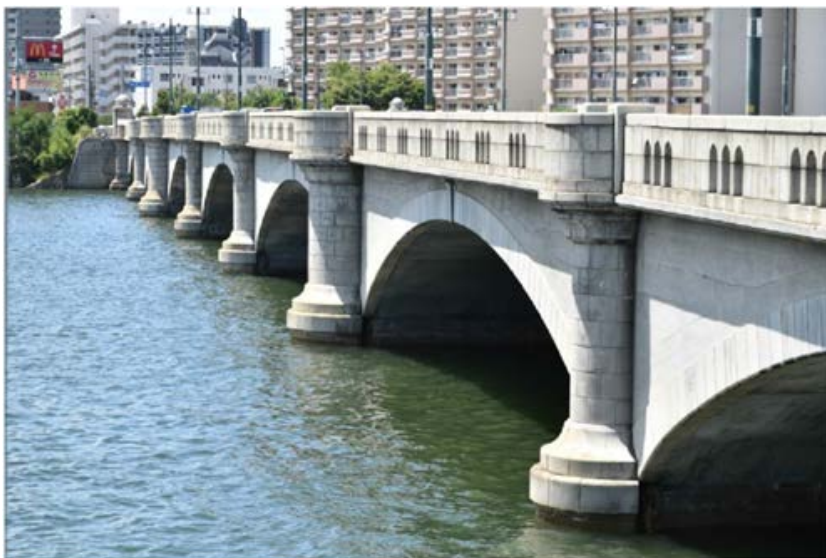
古典的な装飾の半円形の付柱とバルコニー (名島側上流より)
