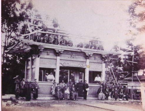
[写真資料1〔建設中の中門〕] 明治35年(1902)頃
