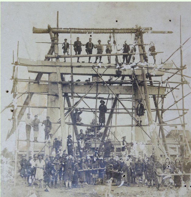
[写真資料5〔建設途中の一ノ鳥居〕] 大正8年(1919)頃
