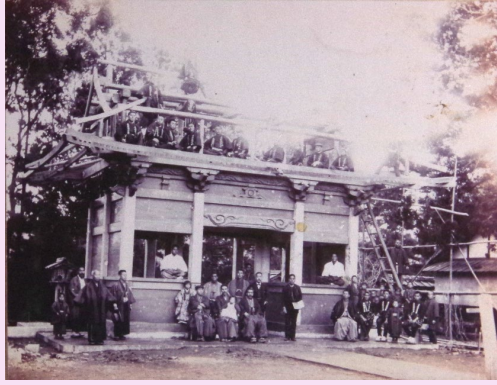
[写真資料1〔建設中の中門〕] 明治35年(1902)頃
