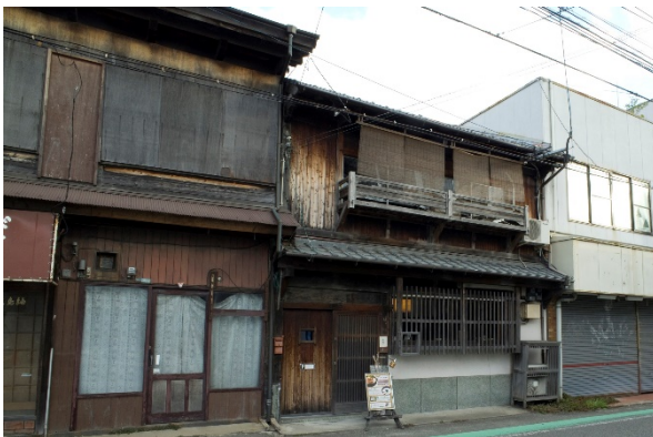
旧柴田家住宅主屋 外観 東面
