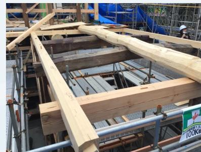
▲ 1階の梁。白い新しい部材の間に古い部材が見えます。
