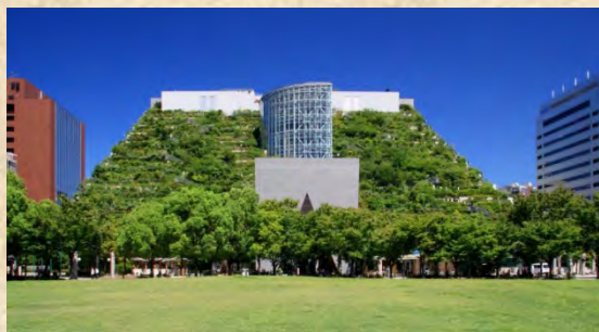
森と建築が融合した天神のシンボル アクロス福岡と天神中央公園
