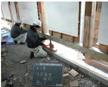
木工事 土台取り替え 家を持ち上げ蟻害が確認された土台はすべて取り替えました
