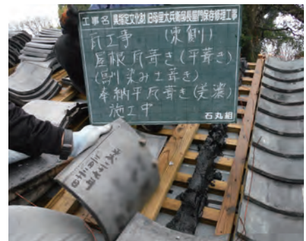
瓦工事 筋葺き 屋根の重量を軽減するため、瓦の谷部中央にのみ土を葺く筋葺きに変更しました
