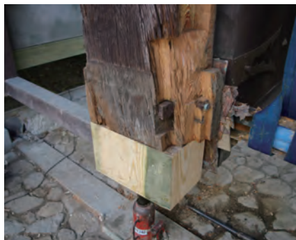
木工事 門柱根継ぎ 柱根の腐朽が著しかったため、家を持ち上げて腐朽部を切除し新材を継ぎ足しました
