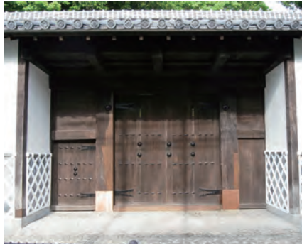
竣工後 門 中央部の下がり修復されました
