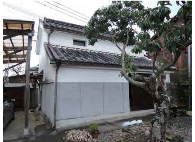
08 土蔵 外観 西から
