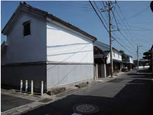
07 土蔵 外観 南東から
