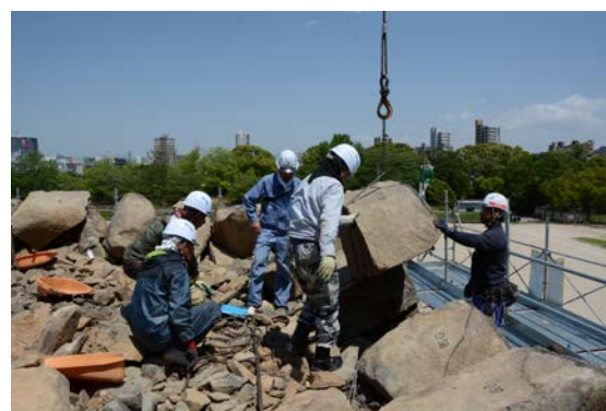
8. 石をクレーンで上げる
