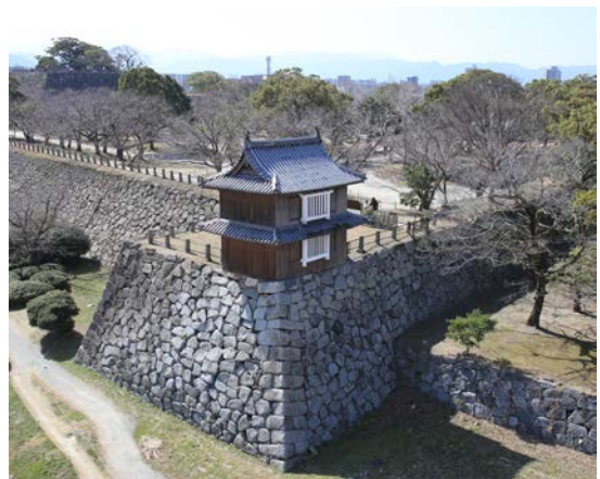
解体前の祈念櫓と石垣
