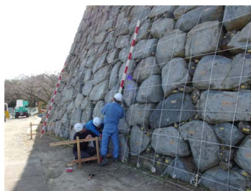
4. 解体前の丁張りの設置 (石垣の傾斜角度の確認)
