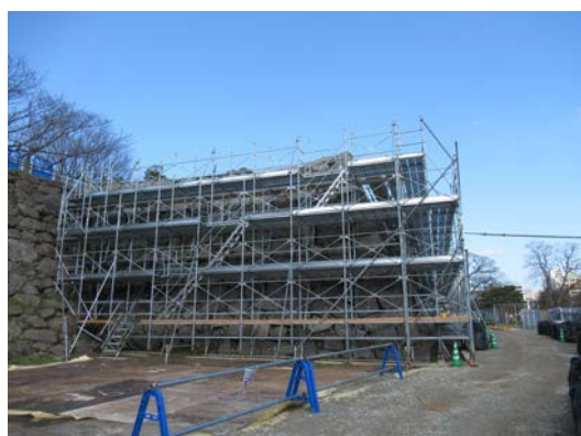
5. 作業用の足場の設置
