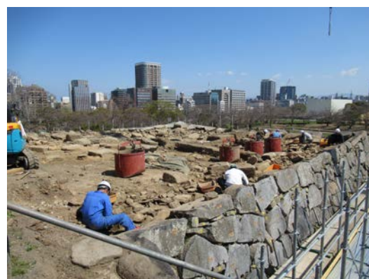
6. 背面の裏込石、盛土の除去
