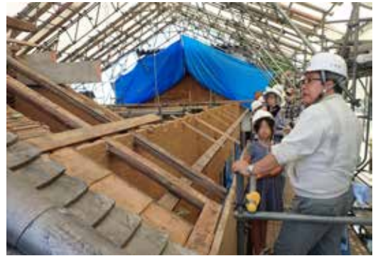
建造物の修理現場の公開
