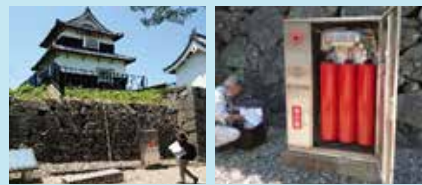
福岡城跡建造物 防火対策
