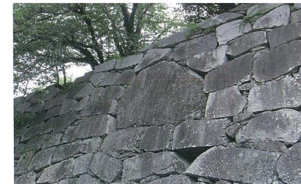
D かがみいし 鏡石 (二ノ丸東御門跡) 藩主の権力の象徴とする説があります。縦に長く背面が短いため、構造的には弱くなります。
