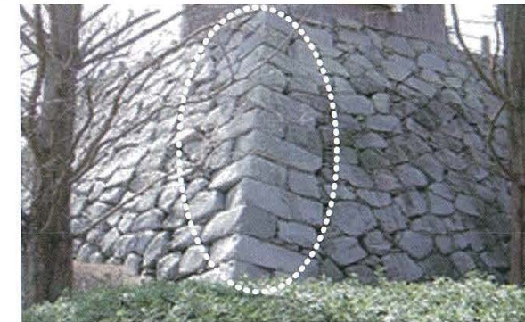
C さんぎづみ 算木積 (本丸祈念櫓石垣北東側) 石垣隅の積み方で、長方形の石材を1段毎に方向を違えて積み上げる方法です。
