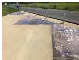
図 5-18 舗装表示 (吉武高木遺跡)
