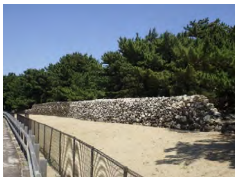
図 3-7 生の松原地区復元整備
