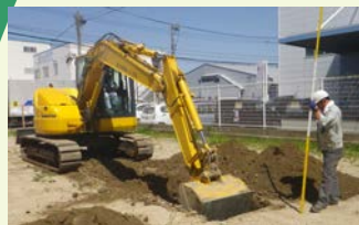
重機で試掘りをする様子
