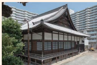
松源寺本堂正側面（南側から）
