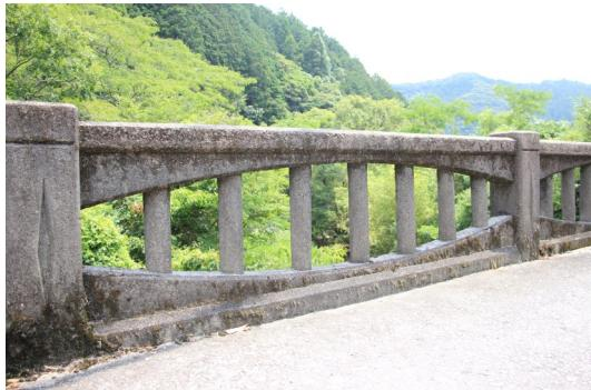
◀曲渕ダムへ向かう市道の途中にかかるコンクリート製の「落合橋」。昭和8年に作られたこの橋は、1900年代初期に流行したアールデコ様式の影響を受けてデザインされたと考えられ<sup>(※)</sup>、高欄部分は、曲線的な開口部を設け内部を柱で分割する、幾何学的なパターンが連続する形をしています。
