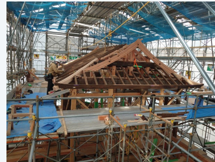
▲櫓の2階部分。これから屋根板を張ります。
