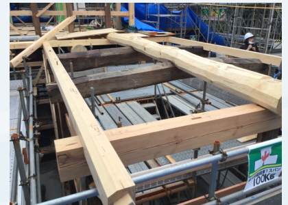
▲1階の梁。白い新しい部材の間に古い部材が見えます。
