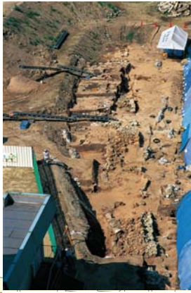
石塁遺構の検出 (第111次調査)
