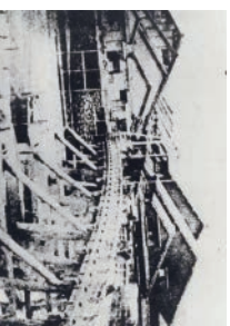
②東中島橋
