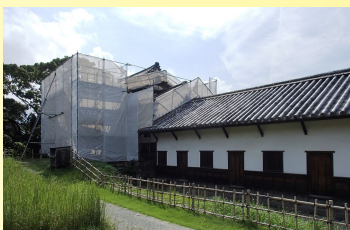
現在工事中の福岡城南丸多門櫓
