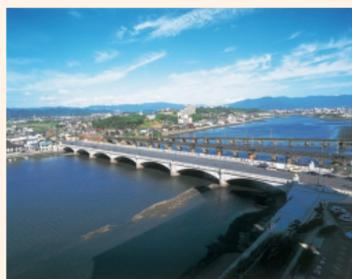
名島橋は、橋長204.1m、幅員25.2m、鉄筋コンクリート造七連アーチ橋で、昭和5年に着工、昭和8年に竣工しました。古典的な装飾をバランス良く配した、長大かつ均整のとれた優美なデザインを特徴としています。国道の全国的な展開と近代福岡の発展を象徴する道路橋として、平成30年3月の文化審議会において、国の登録有形文化財（建造物）に登録するよう答申を受けました（告示は7月予定）。
