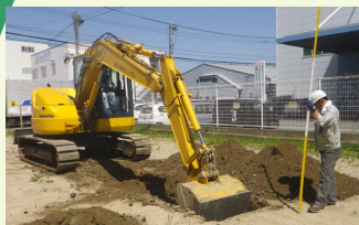
重機で試掘り をする様子
