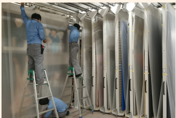
福岡市美術館 粉塵対策としての養生作業
